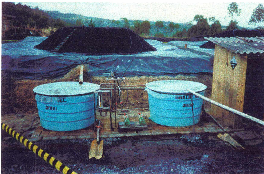
Figura X Vista dos tanques N.ºs 1 e 2 e sistema de bombeio da planta piloto de lixiviação microbiológica de carvão mineral.
