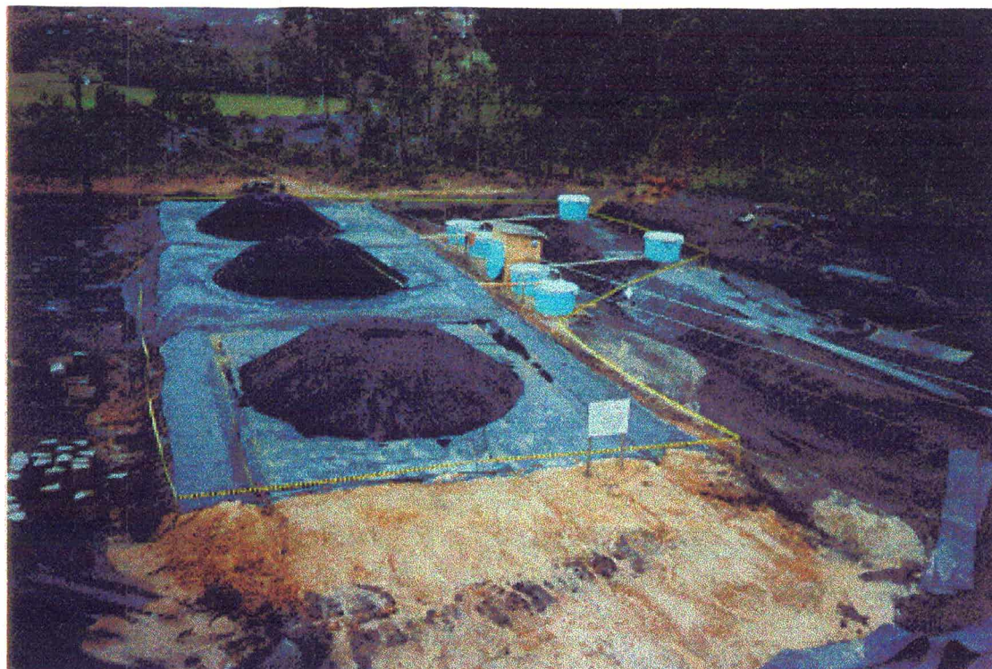
Figura VIII Planta piloto de lixiviação microbiológica de carvão mineral, instalada próximo ao lavador de carvão da Mina São Geraldo.
