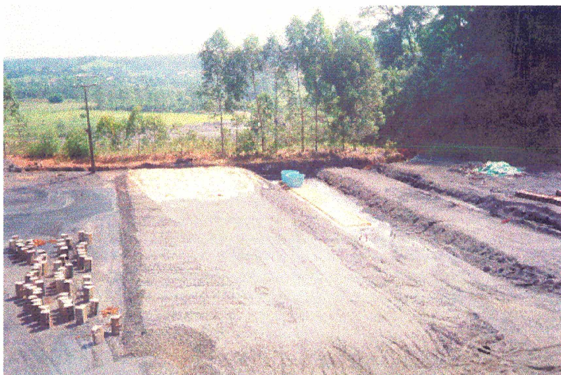
Figura VII Preparação do terreno para instalação da planta piloto de lixiviação microbiológica de carvão mineral, próximo ao lavador de carvão da Mina São Geraldo.
