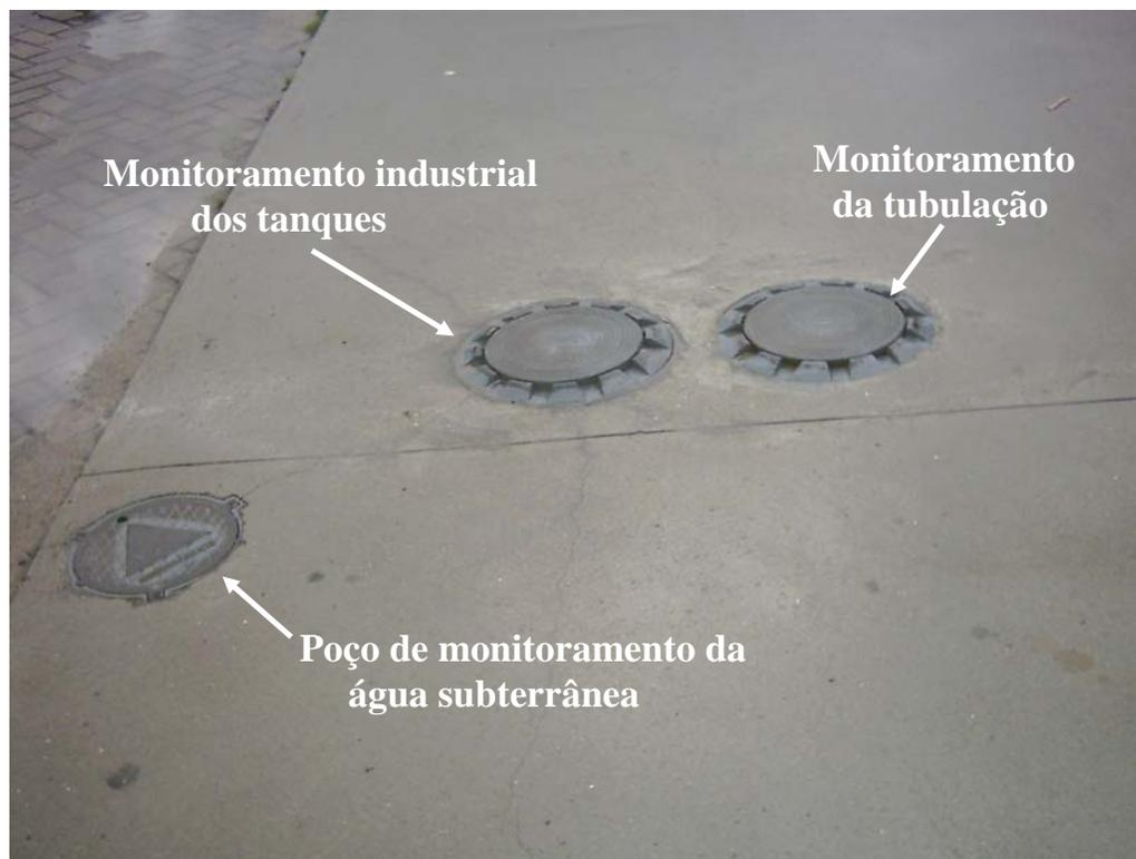
Foto 4: Detalhe dos diferentes poços de monitoramento na área dos tanques.
