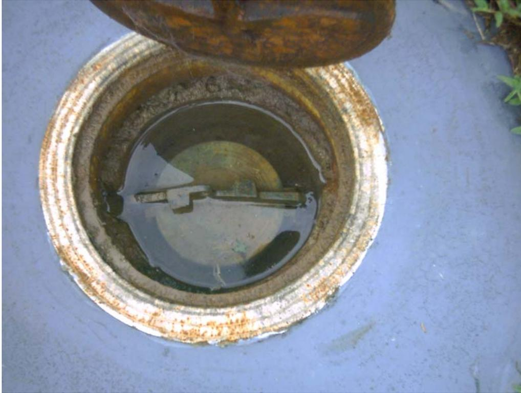
Foto 5: Detalhe do poço de monitoramento da água subterrânea.
