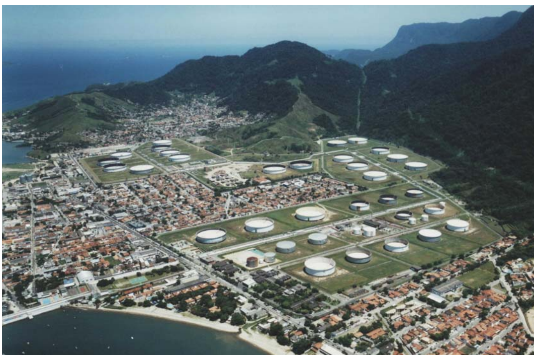
Figura 2 – Fotografia Aérea do Terminal Marítimo Almirante Barroso
