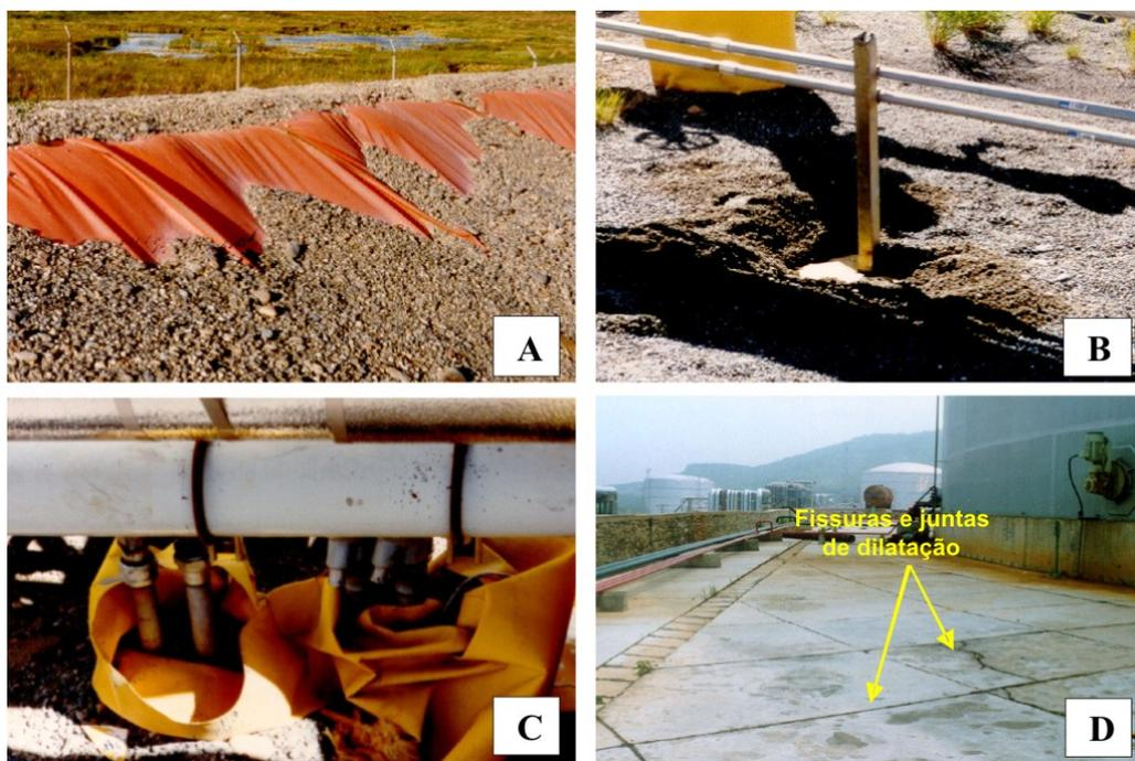
FIGURA 2.1 – Possíveis falhas na impermeabilização em sistemas de contenção: A) Aplicação inadequada da geomembrana, com exposição aos raios solares, podendo resultar em rápida depreciação pela ação do tempo; B e C) Pontos em que as geomembranas não podem conter possíveis vazamentos, como em juntas, conexões e estruturas cravadas no solo; D) Fissuras e juntas de dilatação que podem ser pontos vulneráveis na impermeabilização com concreto.
