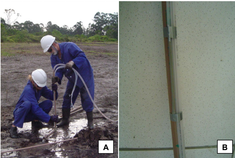
FIGURA 3.7 – A) Instalação de um poço de monitoramento em uma das áreas experimentais (as mangueiras de PEBD são suportadas pelo cano de PVC); B) Detalhe do filtro de tela de aço inox em um dos níveis de monitoramento.
