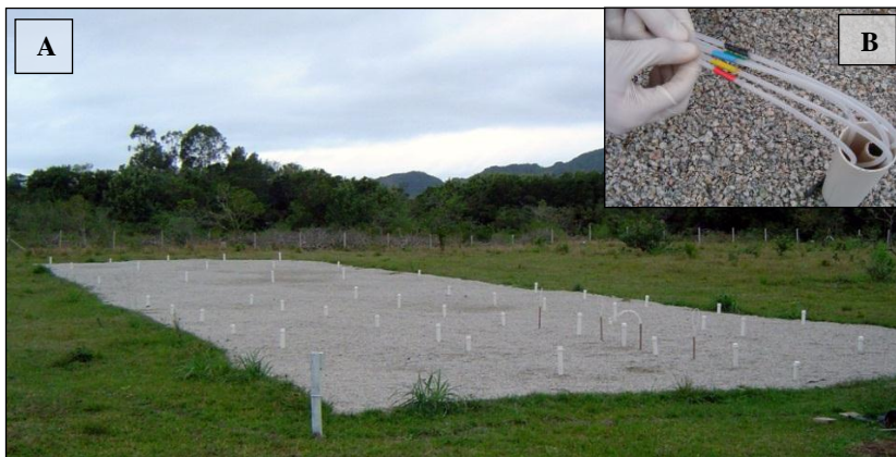
Figura 9 - Visualização geral da área da atenuação natural monitorada (A), e detalhe de um poço de monitoramento multinível instalado (B).
