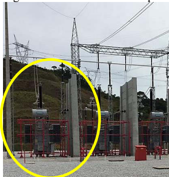
Figura 3.3. Transformador de potência.
