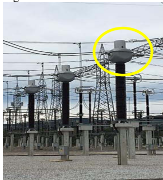
Figura 3.2. Transformador de instrumento.
